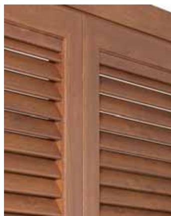
Particolare nodo centrale lato esterno
